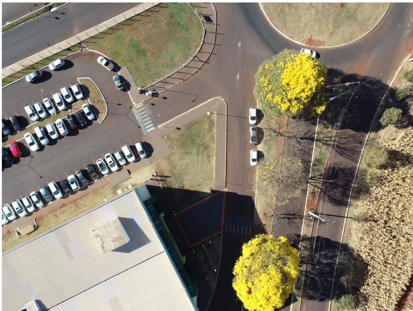
FOTO 02 – LOCAL A SER EXECUTADO PORTAL DA ENTRADA
